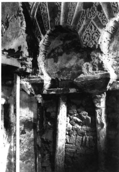
Fig. 38. Detalle del vano central de la triple arquería desde el lado sur; puede apreciarse la proporción de obra antigua conservada, el tipo de fábrica, la decoración de placas de yeso y la policromía. Principios de 1934 (A.T.: nº 2624).
