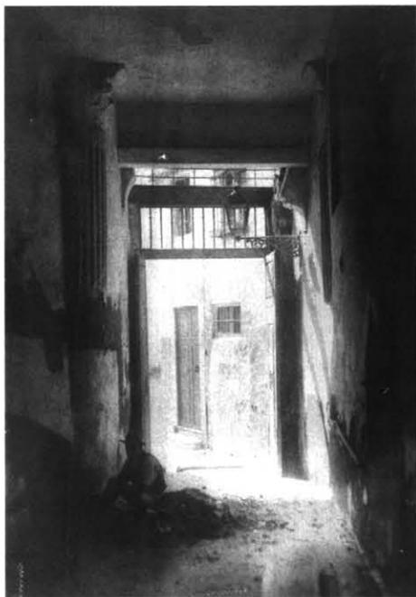
Fig. 64. Obras de exploración en el corredor de acceso o Túnel, y frente norte de la Puerta de las Columnas; eliminación del enlucido para determinar la antigüedad de las fábricas, 1934. Foto Aguilera (A.T.: nº 2468a).
