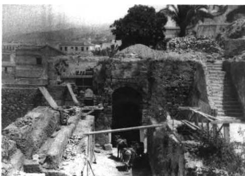
Fig. 62. Idem, una vez eliminado el abovedamiento para devolver parte de la anchura original al corredor de salida, en 1938. Foto J. Temboury (A.T.: nº 2470a).
