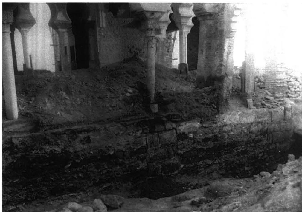
*Fig. 7 Excavación del Patio I tras la reconstrucción del pórtico sur; se aprecia la cimentación de sillería a sogá y tizón. Diciembre de 1935 (A.T.: nº 2564b).*
