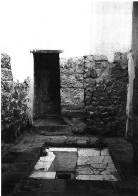
Fig. 107. Estado actual del patio de una de las casas del conjunto de casas del s. XI reconstruida por R. Manzano. Pueden observarse los diferentes tipos de fábrica y los elementos originales del pavimento; los muros enlucidos corresponden al recercimiento.
