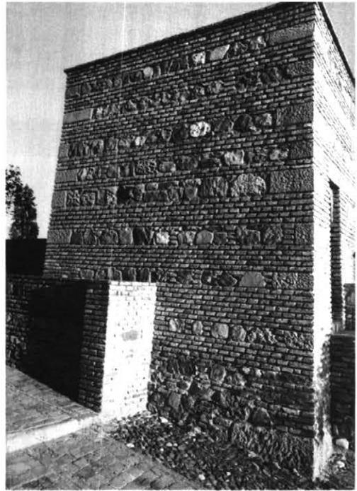
Fig. 74. Idem, estado de la torre tras su restauración por F. Prieto-Moreno a fines de la década de los sesenta; la puerta no ha sido recreada -a diferencia de la torre-, limitándose la intervención a consolidar los arranques de sus jambas ante la ausencia de indicios suficientes acerca de su forma, altura, materiales originales, etc. Estado actual.
