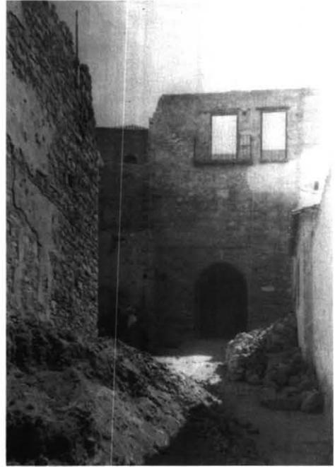
Fig. 93. Idem, durante los trabajos de demolición, en los que se procede al vaciado de su interior excepto por lo que respecta a la bóveda vaída que cubre la puerta propiamente dicha; 1944. Foto Pérez Bermúdez (A.T.: nº 2494b).
