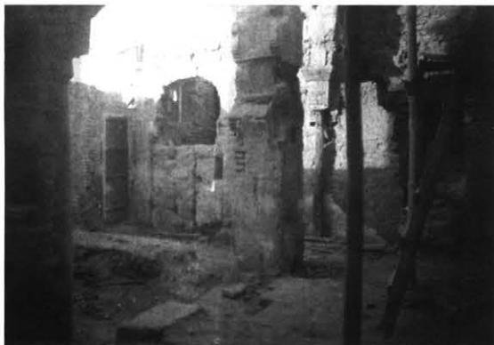
Fig. 43. Pórtico sur del Patio I; estado tras las demoliciones. En el centro aparece un pilar de obra moderna que sustituiría una columna como la que se aprecia a la izquierda, cuya réplica suplantaría nuevamente el mencionado pilar según el proyecto de restauración de ese año, con el propósito de devolverle sus originales relaciones compositivas; septiembre de 1934. Foto J. Temboury (A.T.: nº 2562c).
