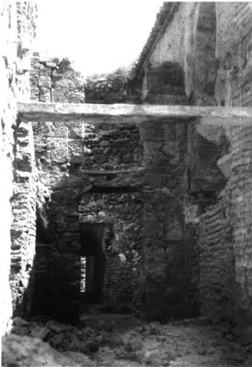
Fig. 39. Interior del palacio del s. XI en los Cuartos de Granada; estado en 1934 tras la demolición de las viviendas tradicionales y los restos de Edad Moderna. Nótase la altura de la fábrica original en sillarejo calizo y el arranque de la rosca del arco en el hueco central. Foto Central Fotográfica (A.T.: nº 2598c).
