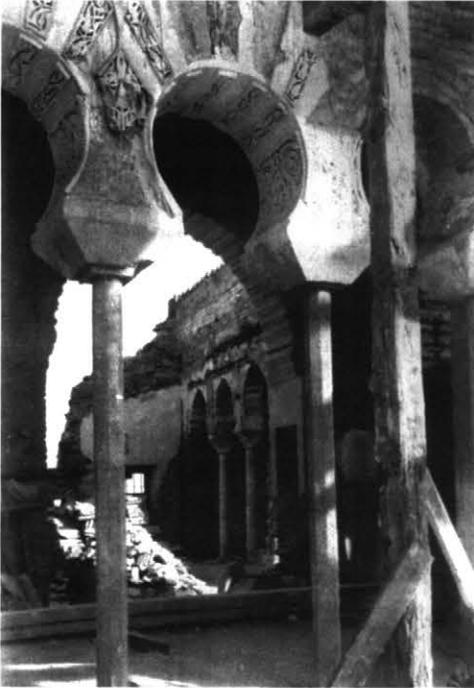
Fig. 42. La arquería de la fig. 38, que ha sido liberada del tabicado moderno y consolidada su decoración, se apea a fines de 1934 en columnillas de hierro y hormigón forradas luego en yeso. Foto L. Torres Balbás (A.T.: nº 2625b).
