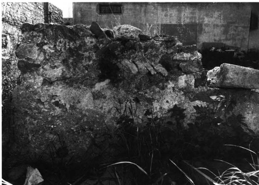
Fig. 16. Detalle actual del aparejo de mampuesto y ladrillo dispuesto a sardinel, trabado y enlucido con mortero de cal y combinado con sillar formando un arranque de muro en el conjunto de casas del recinto superior.
