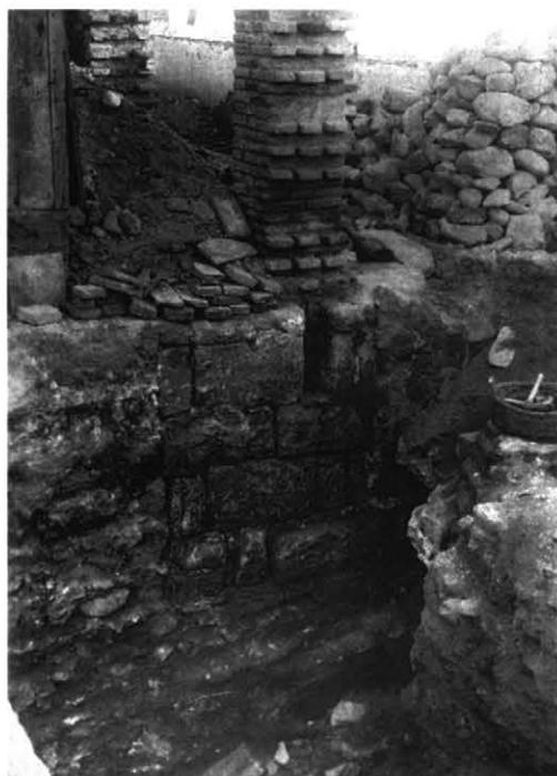
*Fig. 8 Idem, detalle en el que se aprecia el cimiento de cantería además de un pilar reconstruido como jamba del ángulo noroeste del pabellón de arcos entrecruzados; el resalte de las hiladas de ladrillo se dispone para sugerir la continuación del muro al que hipotéticamente iría adosado, sin restituirlo en tanto no existan indicios suficientes. Diciembre de 1935 (A.T.: nº 2564a).*
