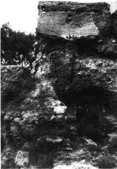
Fig. 96. Muro de la Torre del Homenaje. Fábrica de tapial reforzada con mampuestos, y restos de mortero de cal del paramento exterior; muy deteriorada, inestable y vulnerable. Principios de 1964 (A.T.: n.º 2446e).
