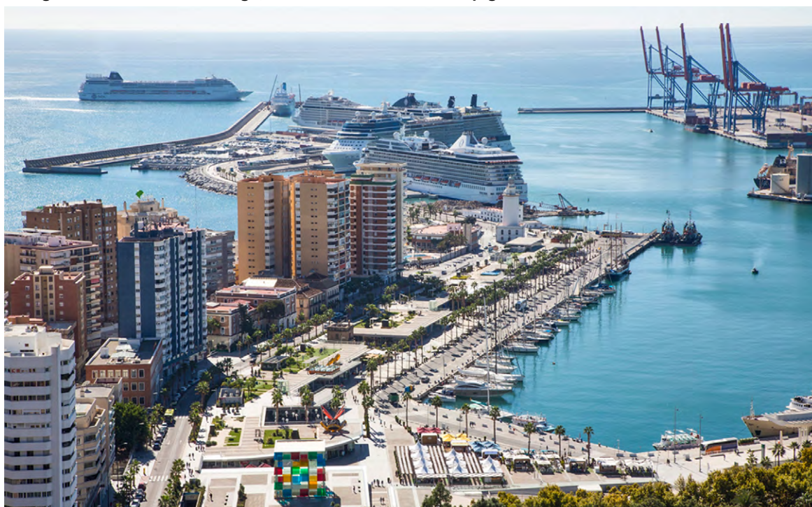
Fotografía 14: Puerto de Málaga, desde el Muelle Uno al espigón de levante.
