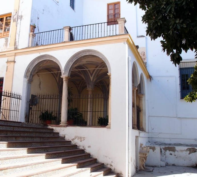
Ilustración 29. Detalle de la logia.
