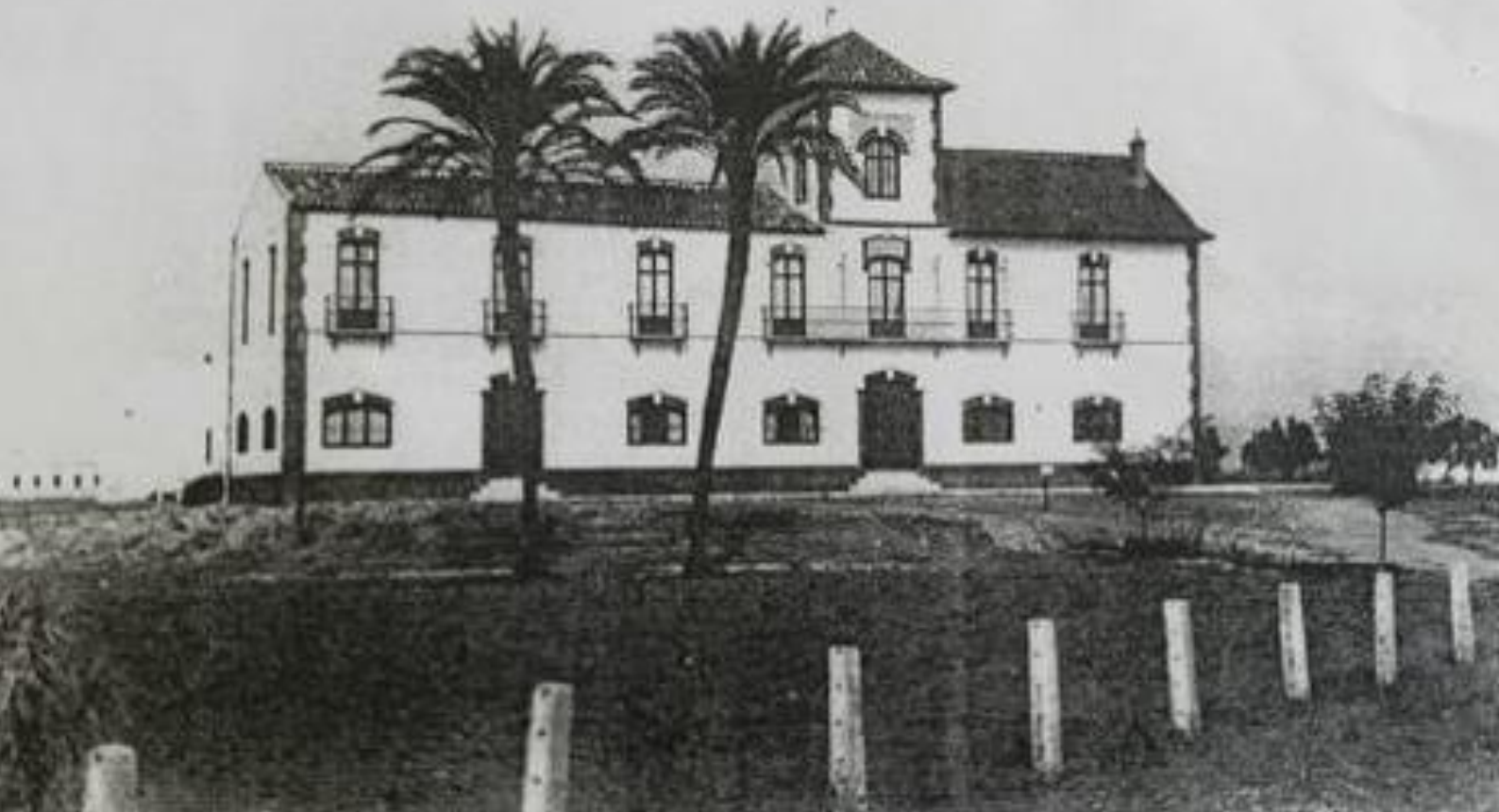
Ilustración 80. Cortijo de la Cruz, Churriana, vendido en 1925 por José Aurelio Larios, Marqués de Larios, al Ayuntamiento y a la Diputación Provincial de Málaga.
